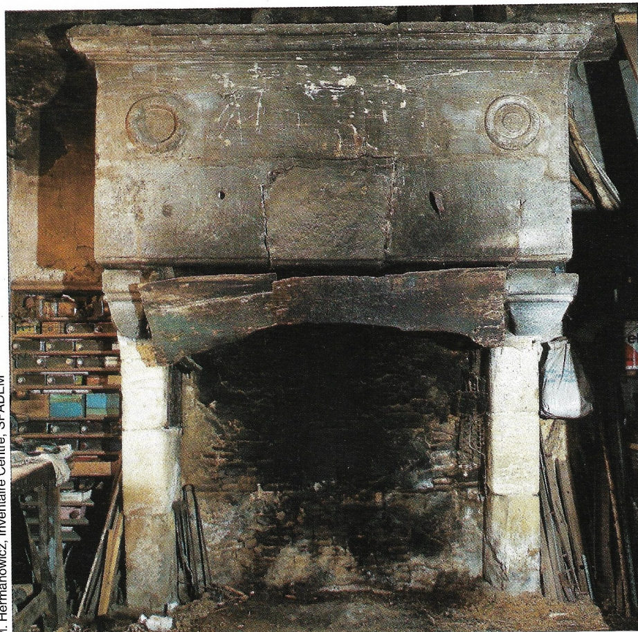
A Rivarennnes, la petite maison rurale de la Salle a conservé sa monumentale cheminée du XVI e siècle, sur le manteau de laquelle sont gravés deux anneaux qu'on retrouve sur les armoiries de Foulques de La Salle, propriétaire du lieu en 1581.
