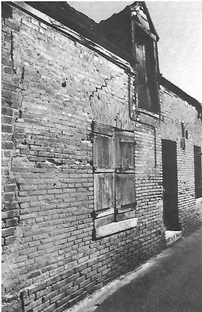
La craie tuffeau qui existe sous tout le canton étant enfouie à des profondeurs variant de 25 à 30 mètres, c'est avec l'argile à silex que furent construites bon nombre des maisons ouvrières de la localité. Le château bénéficia quant à lui d'une noble pierre.
