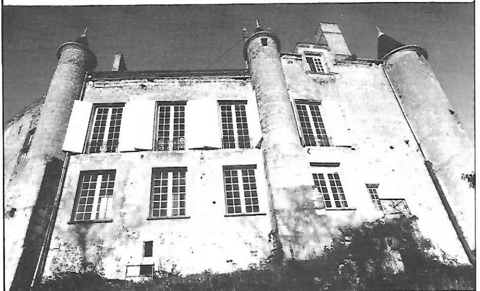
Dominant la ville, le château des marches de la Touraine abrite aujourd'hui l'hôtel de ville. Toutefois, depuis l'été dernier, le public n'a plus à affronter ses nombreux escaliers qui fatiguent les « anciens ». L'essentiel des services a été regroupé dans des locaux plus facilement accessibles, dans l'ancienne orangerie.
