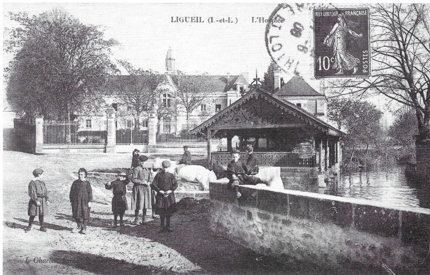
Relié depuis 1885 à Loches et à Esvres (en direction de Tours) par un chemin de fer départemental, Ligeuil connaissait au début du siècle une belle animation. Fondé en 1869, l'hospice cantonal était alors la fierté des Ligoliens. A deux pas du centre-bourg, cet établissement jouit d'un fort beau site, au bord de l'Esves. Le vieux lavoir que la commune inaugura en 1875 a été récemment restauré.
